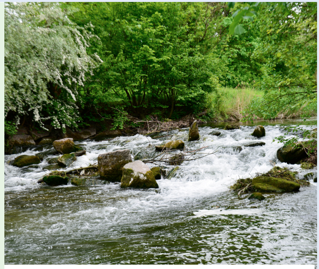
Der ehemalige Betonabsturz wurde muschel-, krebs- und fischgänglich in eine Blockrampe mit ehemaligen Ufersteinen umgestaltet.
