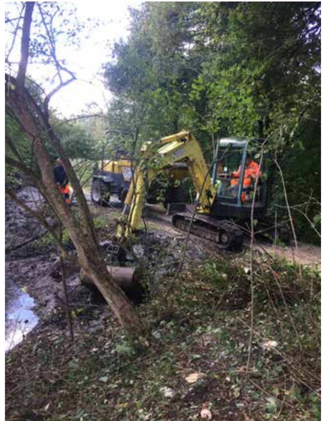
Foto: Teichsanierung mit Bagger
