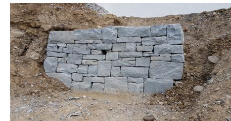
Abb. 3: Die fertige Mauer mit den grossen, schweren Decksteinen. In der Mitte befindet sich eine Nisthilfe für einen Höhlenbrüter.
