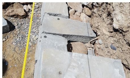
Abb. 2: Das Fundament ist gelegt. Gut zu sehen sind die nach innen ragenden Binder und die Hintermauerung.
