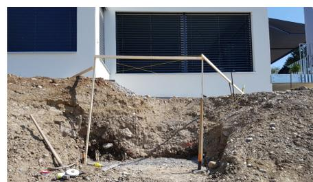
Abb. 1: Nachdem das Schnur- und Lattengerüst aufgebaut ist, kann mit dem Mauern begonnen werden
