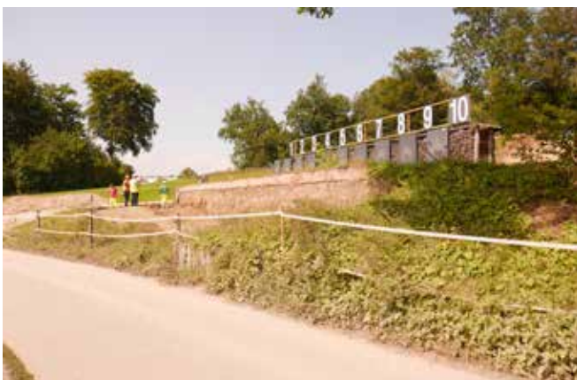
Während der Sanierung des Scheibenstandes wurde das Bodenmaterial auf seine Belastung geprüft, um anschliessend das Material in der passenden Deponie entsorgen zu können. Vor Ort erfolgte dazu eine Einteilung des Aushubs in drei verschiedene Aushubskategorien.
