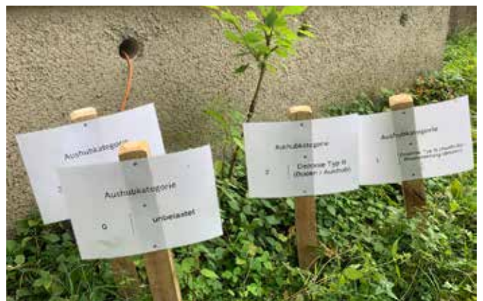
Während der Sanierung des Scheibenstandes wurde das Bodenmaterial auf seine Belastung geprüft, um anschliessend das Material in der passenden Deponie entsorgen zu können. Vor Ort erfolgte dazu eine Einteilung des Aushubs in drei verschiedene Aushubskategorien.
