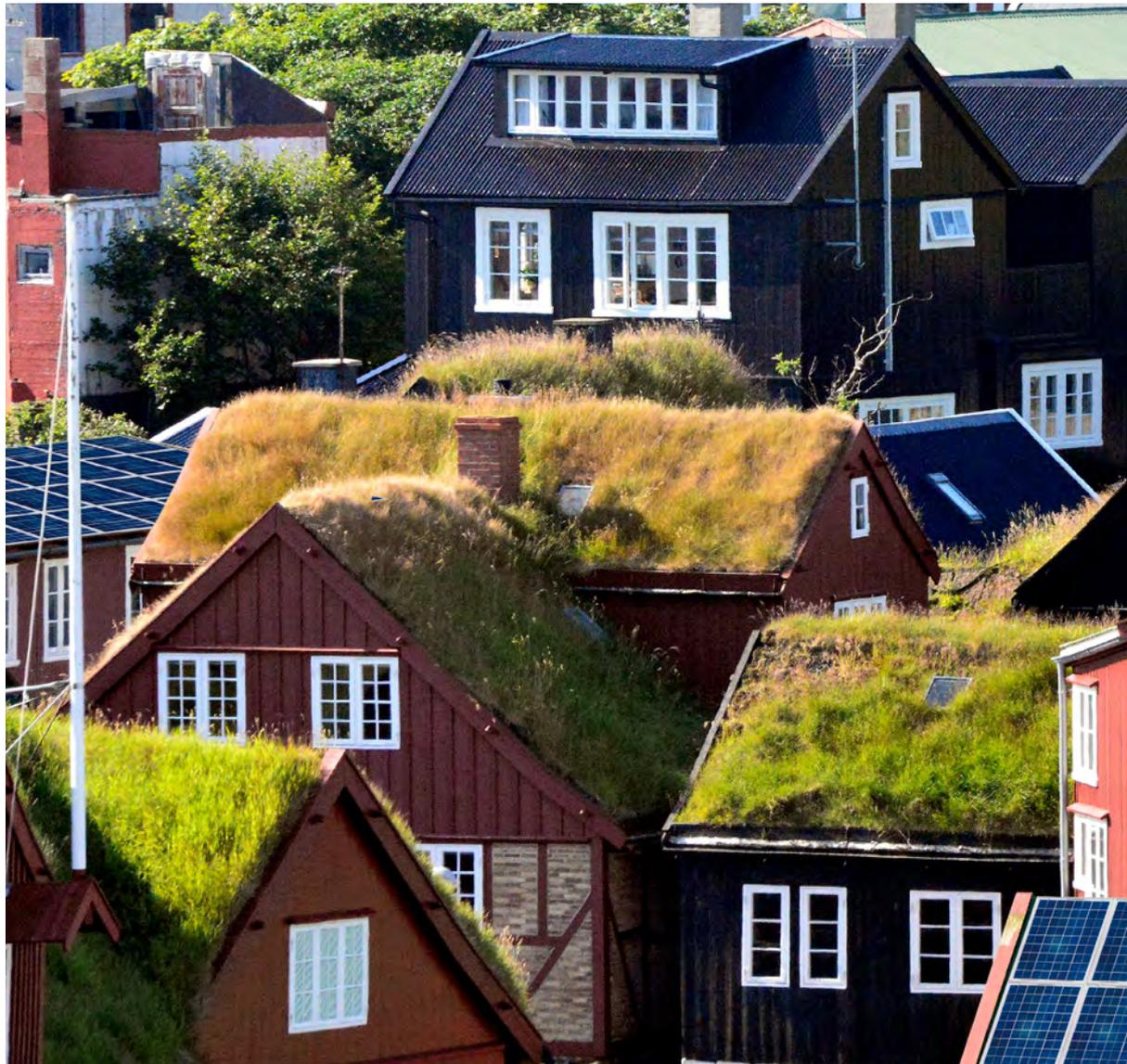
die saisonbedingten Temperaturschwankungen. Durch die Verdunstung des gespeicherten Regenwassers kühlt sich die darüber liegende Luftschicht sowie das darunter liegende Gebäude ab. So ist die Raumtemperatur unter begrünten Dächern 3 bis 5°C tiefer als bei unbegrünten Dächern. Wenn im Sommer die Räume aktiv klimatisiert werden müssen, so kann durch die Begrünung der Dachflächen viel Kühlungsenergie eingespart werden.
