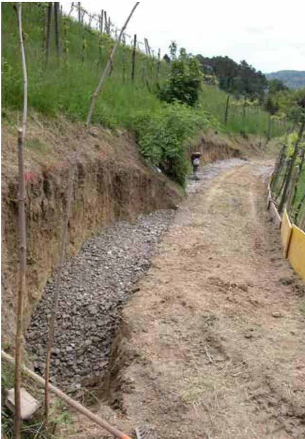
Abb. 10: Fundament aus Schotter.
