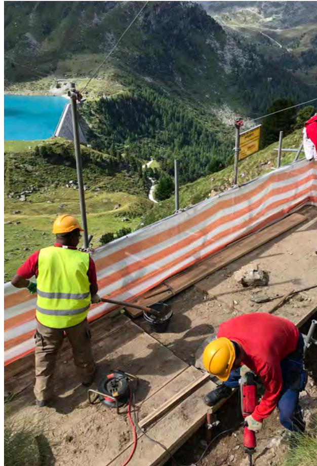
Die Wiederherstellung des Suonenwegs war der Anlass für die Sanierung der Trockensteinmauer.
