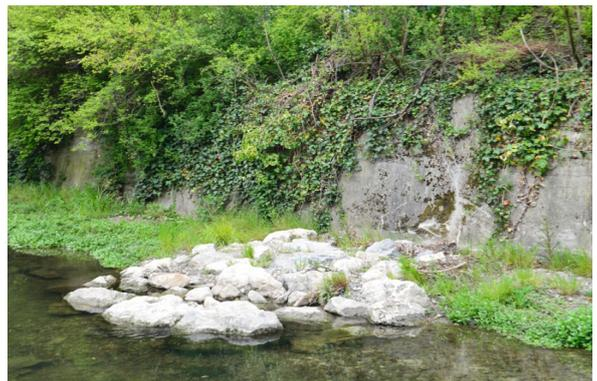
*Auch bei schon verbauten Gewässern ist eine behutsame Revitalisierung durch Einbau naturnaher Strukturen möglich!*
