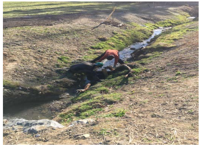
Abb. 4b: Gewässerwart*innen bauen Wurzelstrunke in Absprache mit dem Fischereiaufseher und Gemeinde ein.
