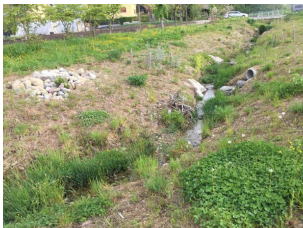
Abb. 5s: Ingenierbiologische Massnahmen mit Uferfaschinen, Wurzelstrünken und Sodenpflanzungen.
