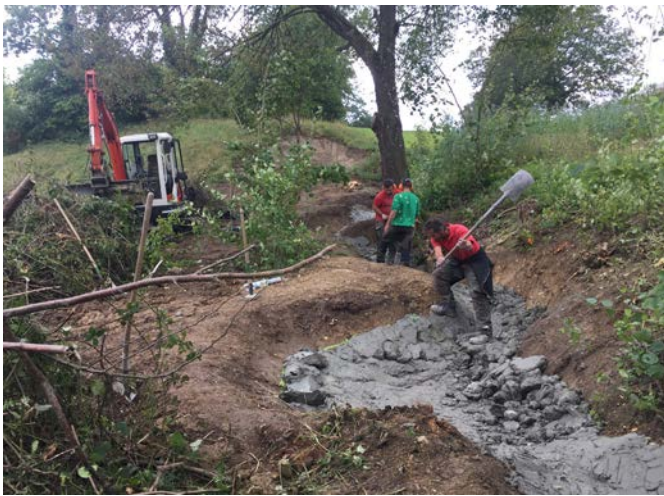
Abb. 3b: Referenzprojekt neue Tümpelkaskade in Kyburg.
