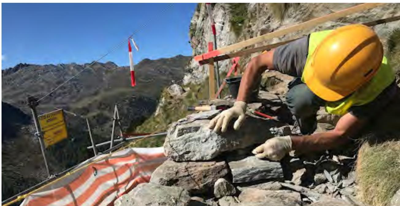
Abb. 21: Anspruchsvoll: Bau einer Trockensteinmauer im Wallis.
