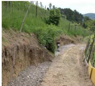
Abb. 6: Fundament aus Schotter
