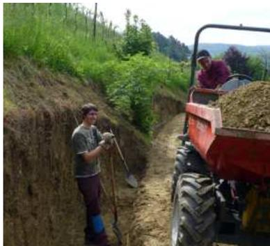
Abb. 5: Aushub der Stufe und des Grabens.
