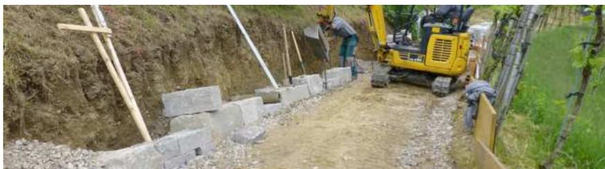
Abb. 7: Ausrichten der Fundamentsteine mit dem Bagger.
