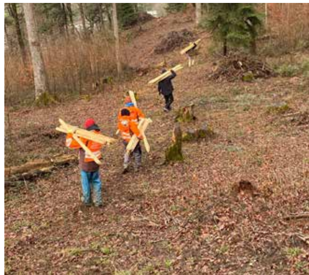
Abb. 11: Zivis beim Zaunbau.
