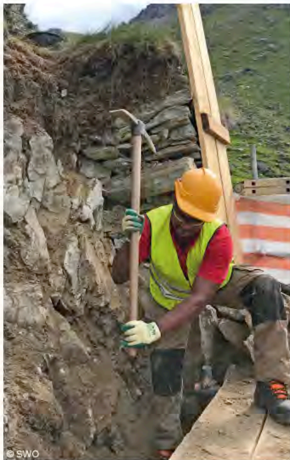
Rénovation d'un mur en pierres sèches à Nendaz. Renovation einer Trockensteinmauer in Nendaz.
